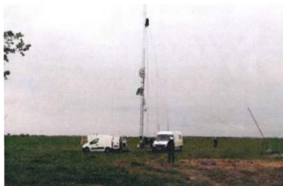
L'installation sur site du mât de mesure de 80 mètres de haut
