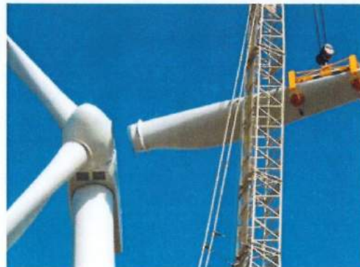
Assemblage d'une pale
