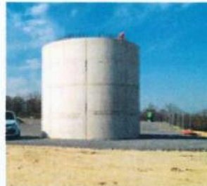
Socle d'une éolienne
