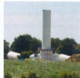
Premier tronçon de mât installé
